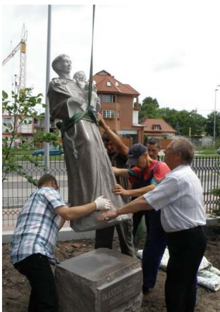
Instalacja pomnika św. Antoniego
