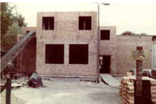
Budowa domu parafialnego
